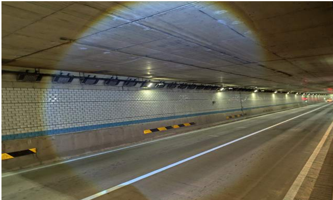
BOX구간 벽체 전경
