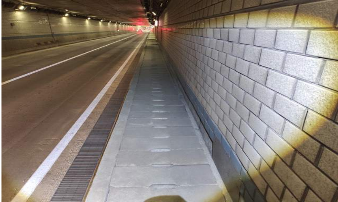
NATM구간 공동구 전경
